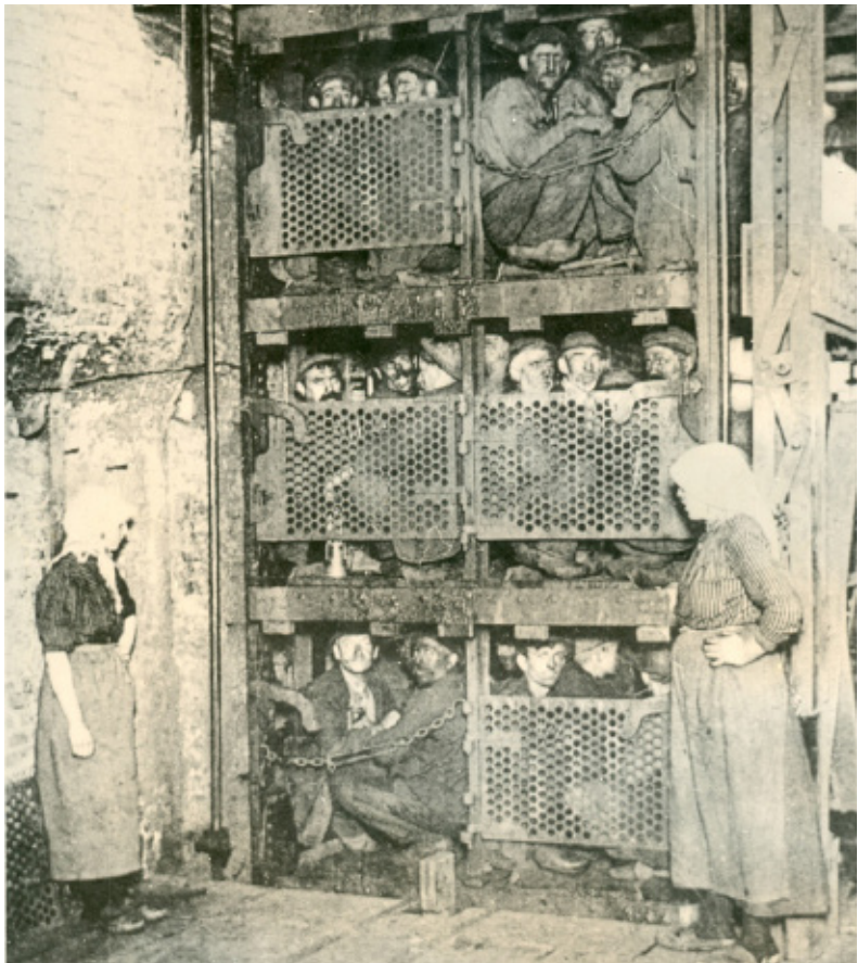
Les ouvriers mineurs dans la cage - Coll. ILHS - Institut Liégeois d'Histoire Sociale
